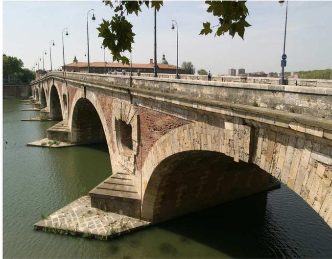
Abbildung 7: Pont Neuf über die Garonne; gut erkennbar die „Löwenmäuler“, die als Überlaufschutz dienen
